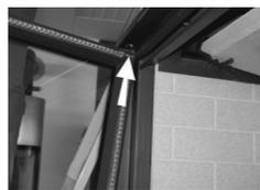
2. Faites ensuite pivoter la porte et glissez-la dans l'ouverture inférieure à l'aide du pivot inférieur. Déplacez (faites pivoter) légèrement la porte pour que la vis à 6 pans creux glisse dans le logement.
