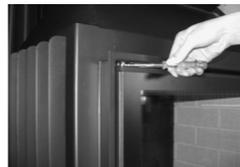
2. Faites pivoter la porte. Serrez ensuite la vis à 6 pans creux sur la charnière inférieure à l'aide d'une clé hexagonale 3 mm.
