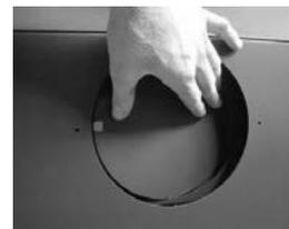
2. Fixez la buse d'air de combustion de 125mm voire 150mm au tuyau à l'aide d'un collier de serrage. Puis fixez la buse avec 3 vis à l'arrière de la chambre de combustion.
