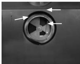
3. Le raccordement d'arrivée d'air de combustion va être inséré dans la buse d'arrivée d'air de combustion. Celle-ci sera alors fixée au corps de chauffe de la cassette à l'aide des deux vis restantes.
