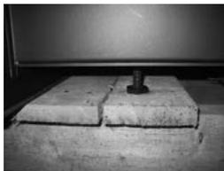
Si la cassette doit être ajustée à posteriori, les pieds peuvent être atteints via la chambre de combustion. Il faut pour cela démonter le revêtement de la chambre de combustion et régler les vis à l'aide d'une vis cylindrique à 6 pans creux. (ceci n'est pas possible sur la cassette Linear XS 500)
